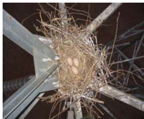
Ninho com ovos próximo ao isolador central
