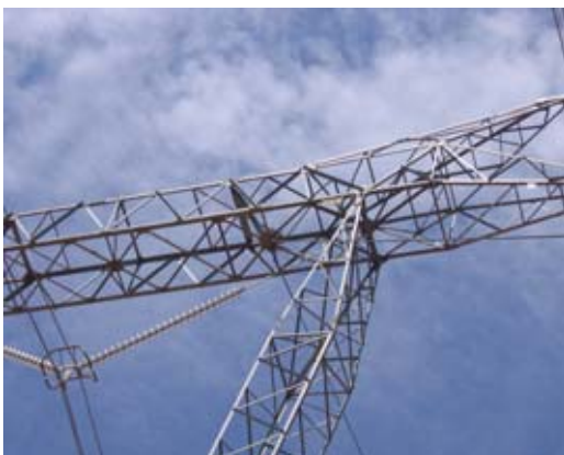
Ninho próximo a cadeia de isoladores - V
