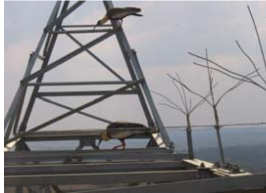
Curicacas na estrutura e sistema de proteção
