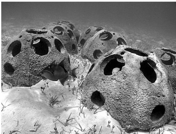
Figura 2 – Reef balls feitos em concreto estão entre as categorias de recifes artificiais pré-moldados mais utilizados no mundo (Fonte: Reef Ball Foundation, Inc.).
