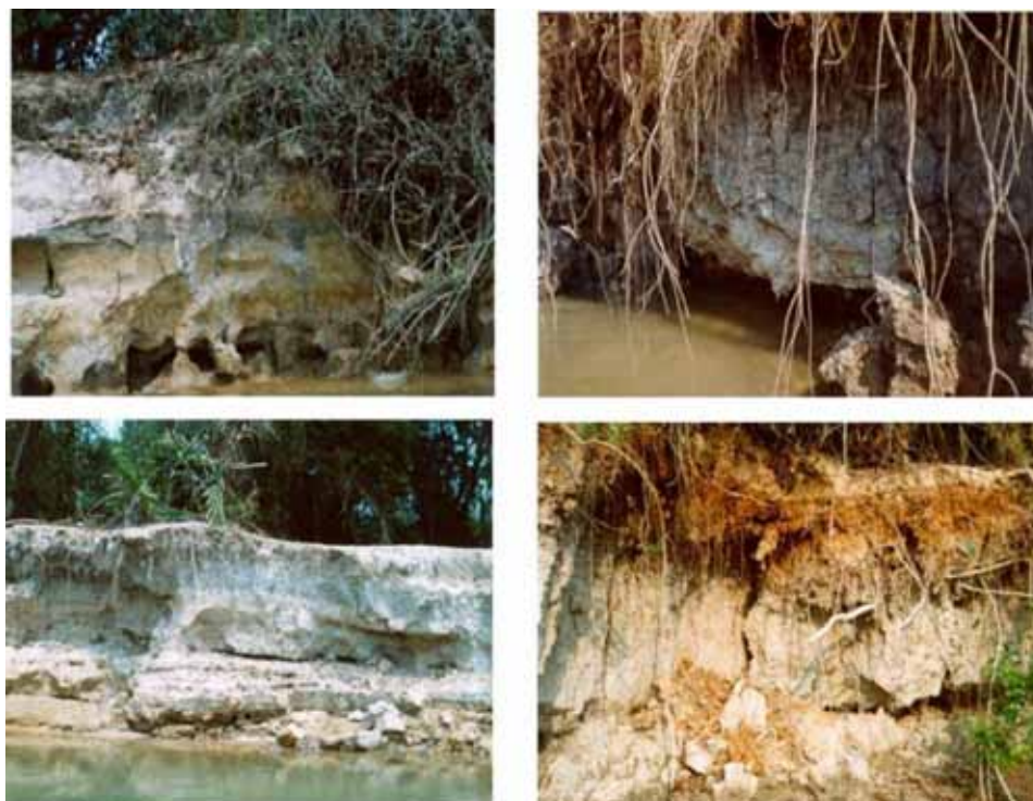
Figura 3 - Formas erosivas no rio Paraguai no segmento superior, onde é possível observar a base das margens solapadas ocasionando a queda de blocos.
