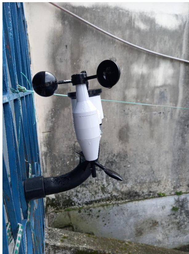
Figura 1. Estação meteorológica de baixo custo instalada nas dependências do Prof. Rafael Coll Delgado.
