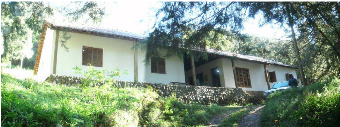
Vista geral do alojamento do Parque Nacional da Serra da Bocaina, localizado na portaria do Parque.
